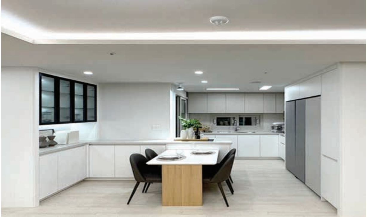
성남 복정2블럭 내모델하우스 주방, 일반가구 제작 설치
